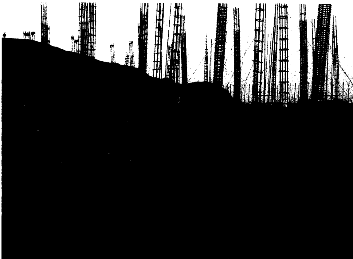
COLOCADO DE ACERO
